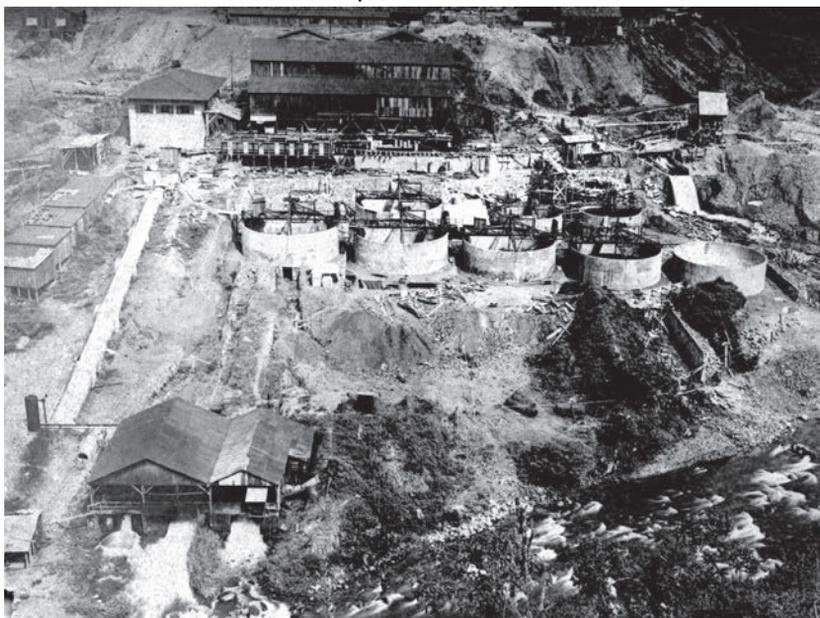
**Nota:** Las canaletas de madera descargaban el agua directamente en el río Amarillo en tanto que los relaves eran utilizados para nivelar un terreno contiguo, ubicado en el lado izquierdo de esta foto. Dicho terreno se convertiría luego en el famoso campo de fútbol. Fuente: ETSA (1917ca).
