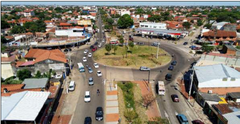
Figura 3. Tramo piloto previa la intervención
